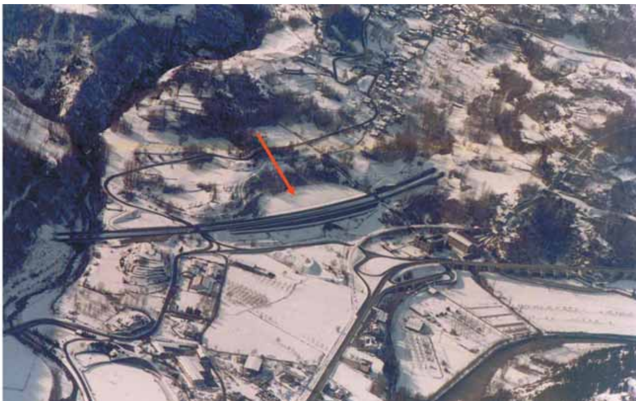
Luogo dell'incidente indicato dalla freccia.
