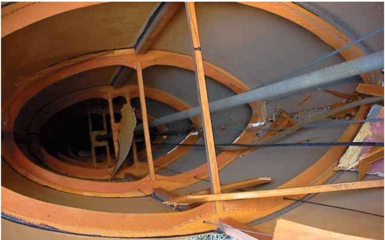
Cavi metallic e rinvii del tronco di coda integri.
