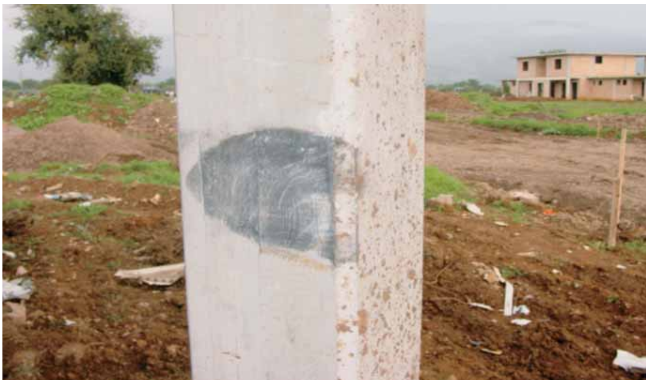
Impronta pneumatico semicarrello destro.
