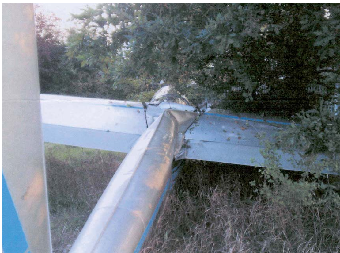
Primo piano dei danni.
