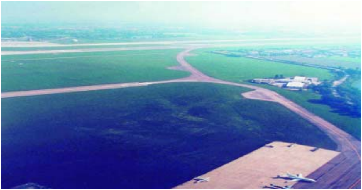
Foto 14 - Ripresa aerea della TWY R6.
