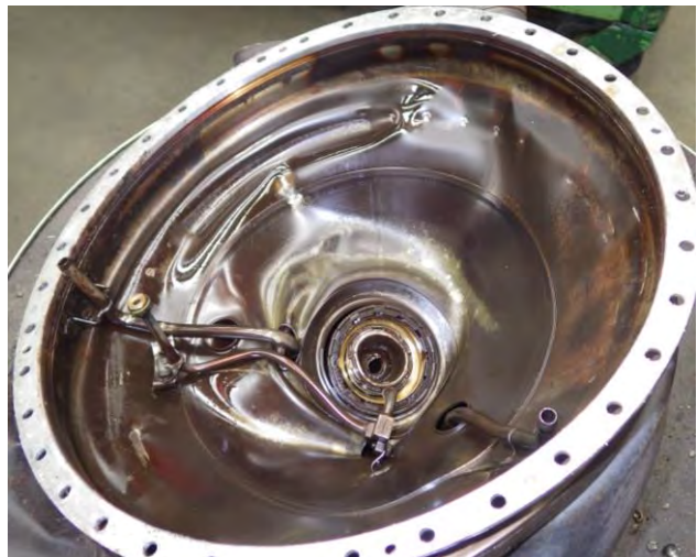
Foto 30: supporting cone vista interna.
