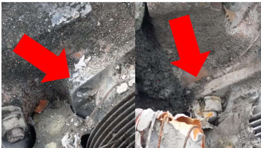
Foto 15 e 16: dettaglio della condizione dei dadi di serraggio del motore spezzati o danneggiati.
