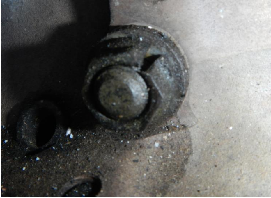
Foto 44: esempio di danneggiamento dovuto alle alte temperature di un post-crash fire , fornito dal costruttore del motore (foto Continental Aerospace Technologies).
