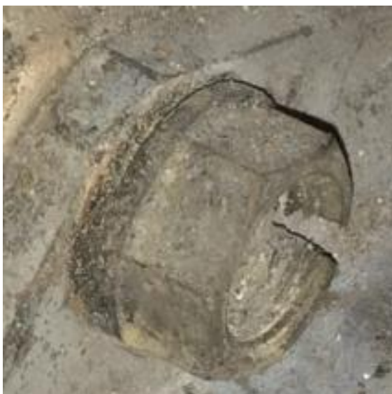
Foto 43: particolare delle condizioni di uno dei dadi di fissaggio.
