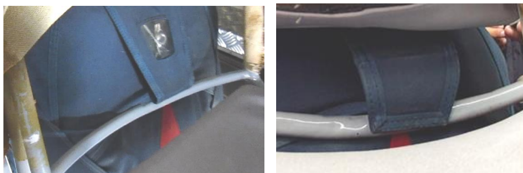
Foto 45 e 46: apertura della copertura di protezione del sistema di chiusura a seguito della interferenza con la traversina metallica.
