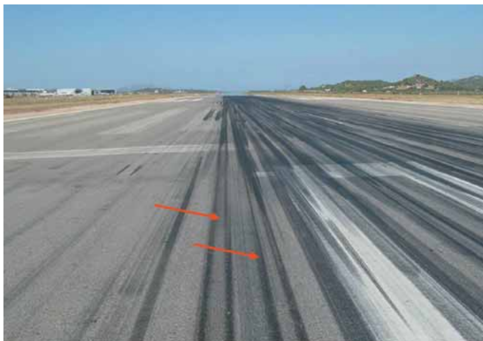
Strisciate provocate dalle ruote durante l'atterraggio (indicate dalle frecce).
