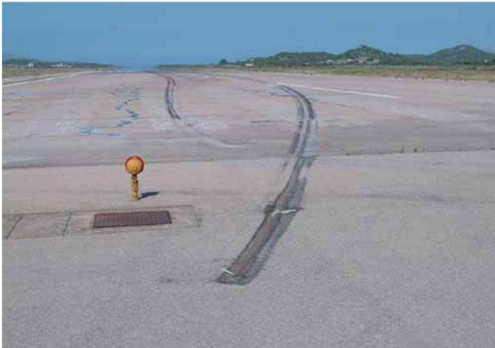
Tracce al suolo nell'ultimo tratto di pista.
