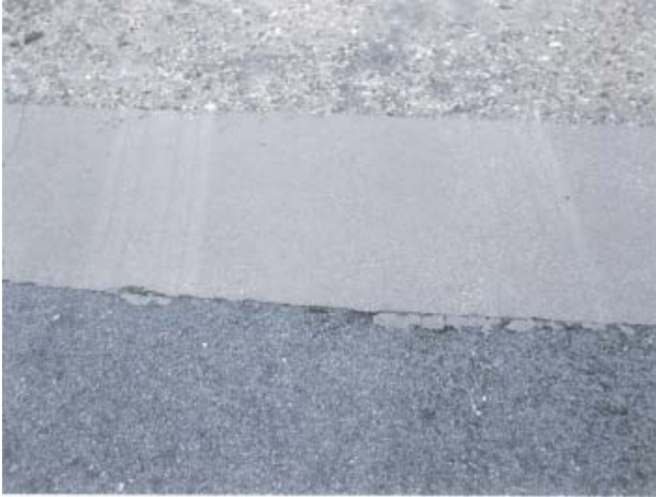
Cordolo di collegamento tra la pista e la Stop Way posizionato alla fine della seconda freccia bianca (si veda l'Allegato B)
