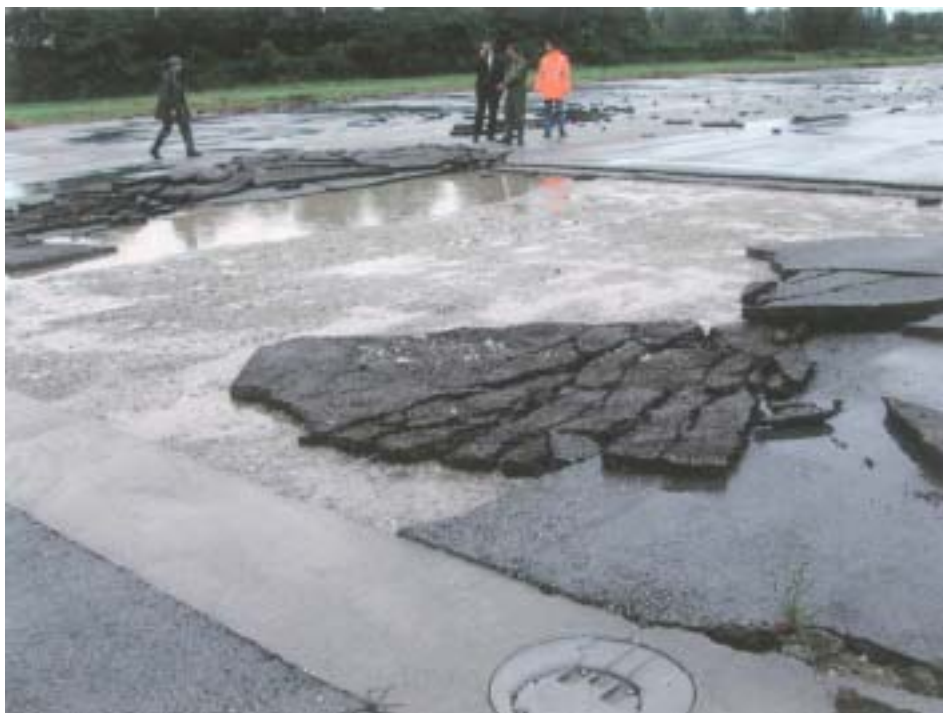
Particolare del cordolo contenente le luci pista
