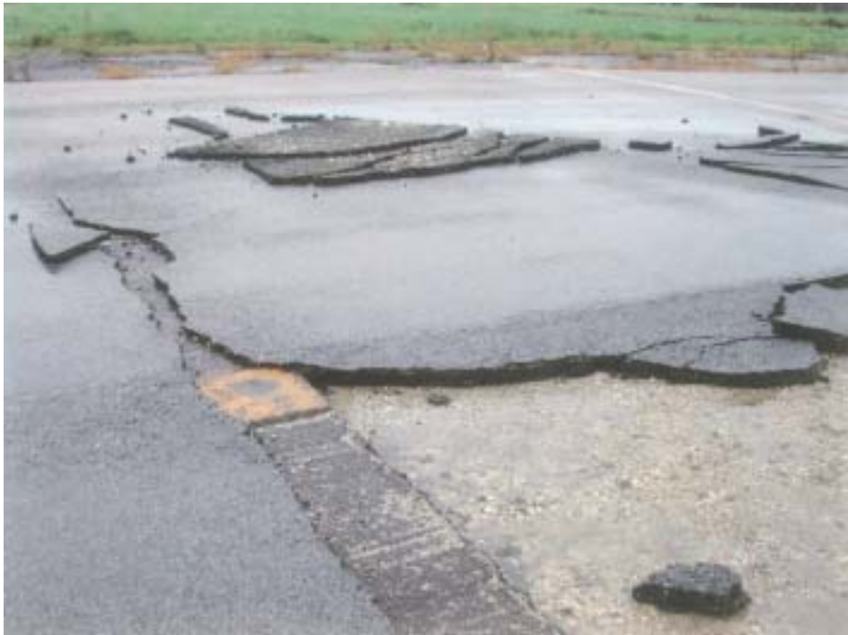
Particolare zona divelta dal flusso d'aria dei motori
