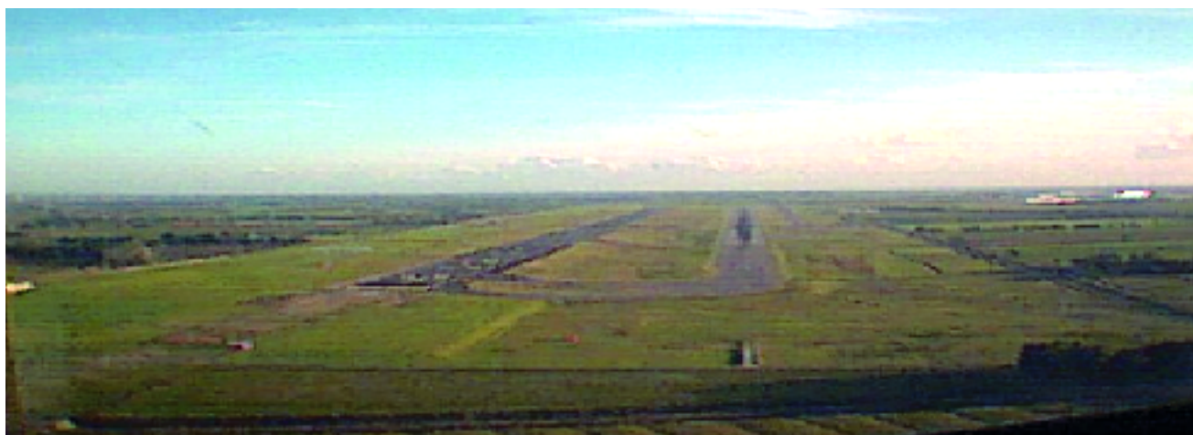
Foto n. 1: vista da Nord delle piste 16C e 16L.
