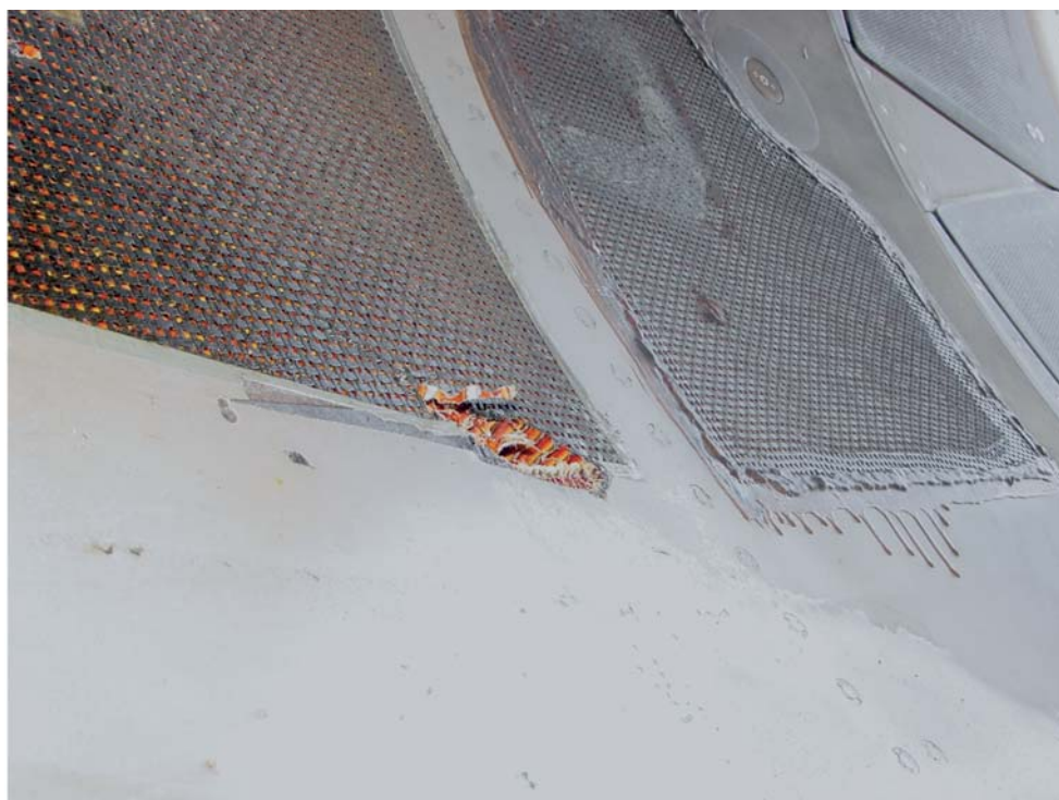
Danneggiamenti del fan case motore destro (dettaglio).
