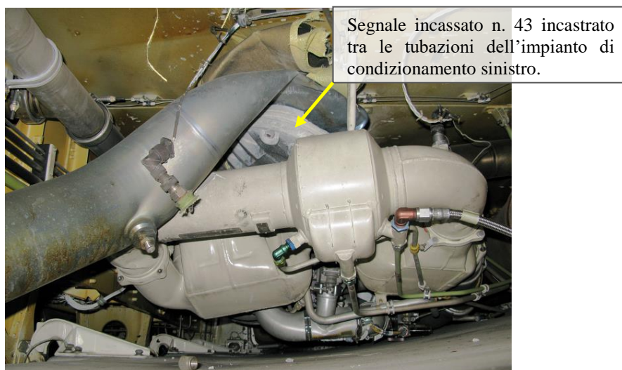
Foto 4: segnale incastrato nel vano sinistro dell'impianto di condizionamento.
