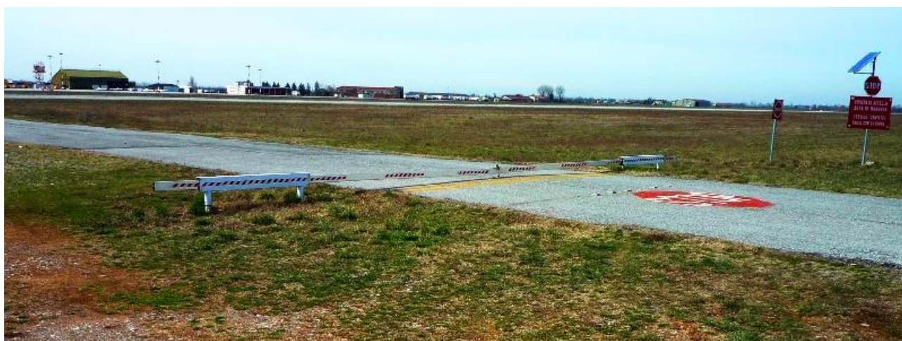
Foto 3: Il luogo dell'evento, in prossimità della barra antintrusione posizionata sul raccordo.
