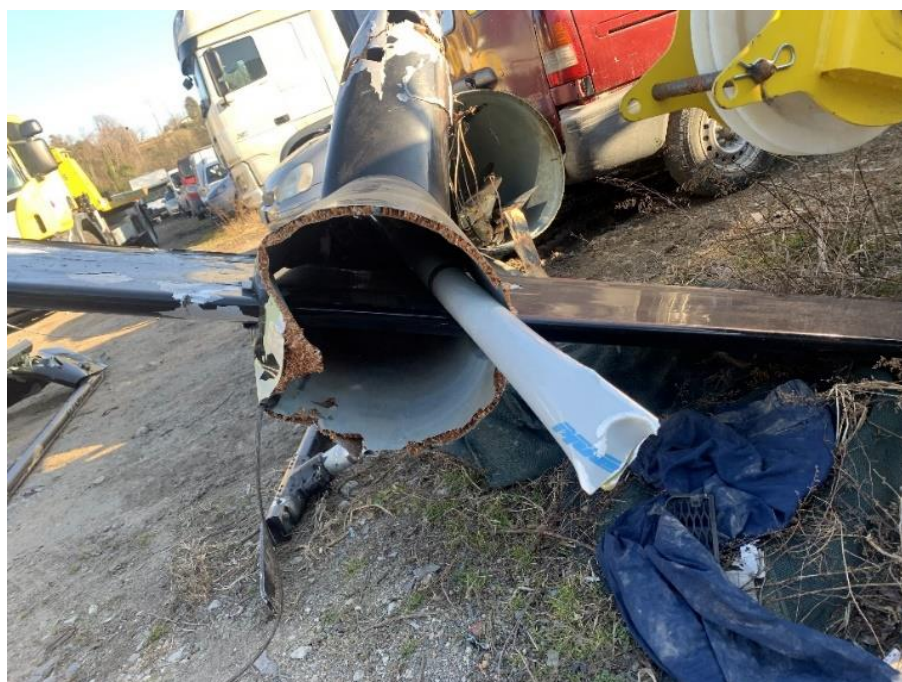
Foto 7: rottura dell'albero di trasmissione.
