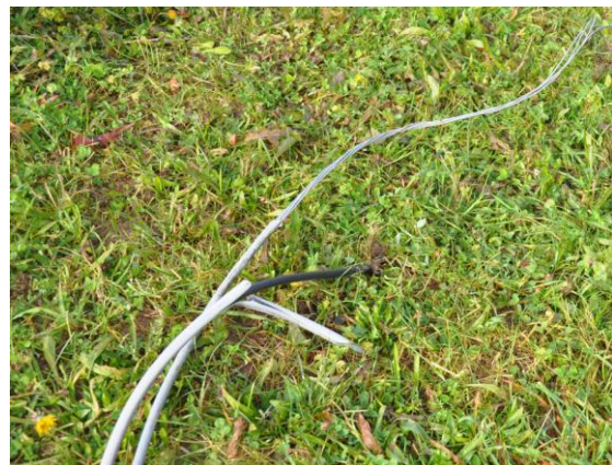
Foto 9 e 10: particolare dei danni alla linea elettrica di media tensione.
