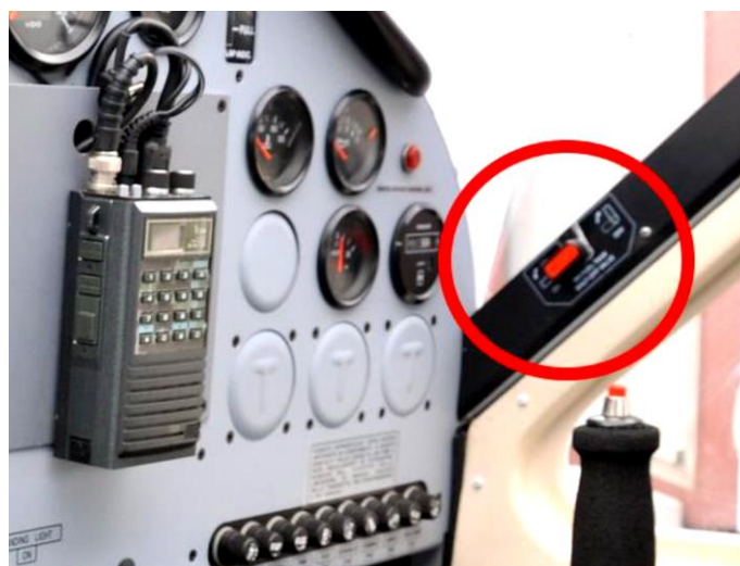
Foto 21: posizione shut-off carburante serbatoio destro Tecnam P92 Echo S.
